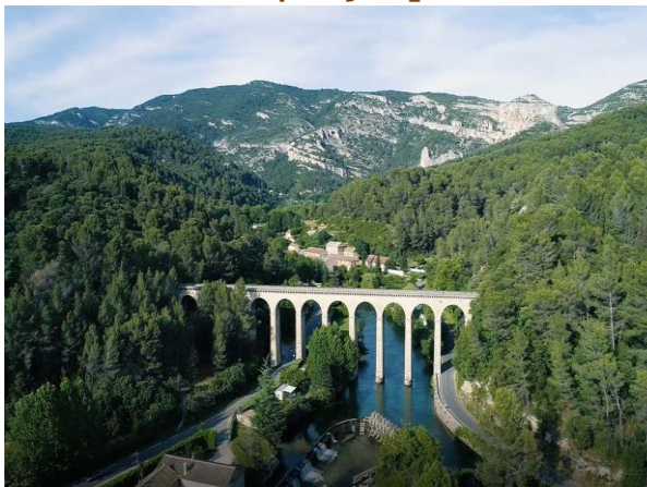
Aqueduc - Fontaine de Vaucluse @ OTI CCPSMV
